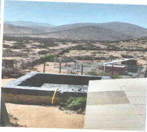
Estanque vacío, se limpió y sanitizó. 50.000 Litros de agua retirada
